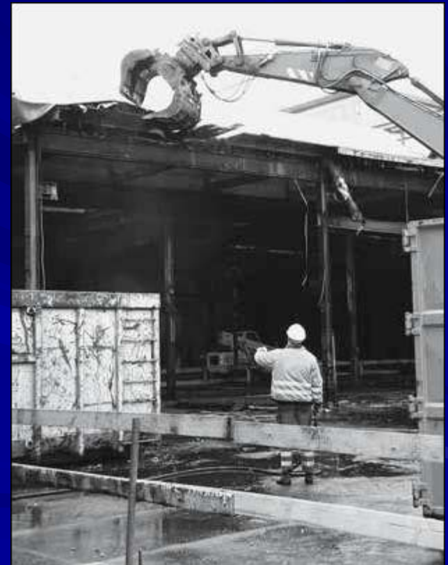
Delimitazione del cantiere
